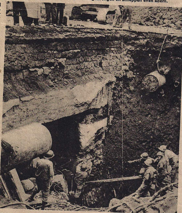
VERNIETIGING EN RECONSTRUCTIE. In Napels repareren Amerikaanse soldaten gas- en waterleidingen, die door de Duitschers opgeblazen waren.
